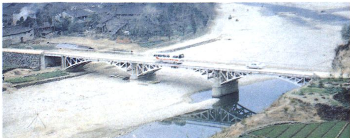
头(陀)白(鹤殿)公路屿头桥
