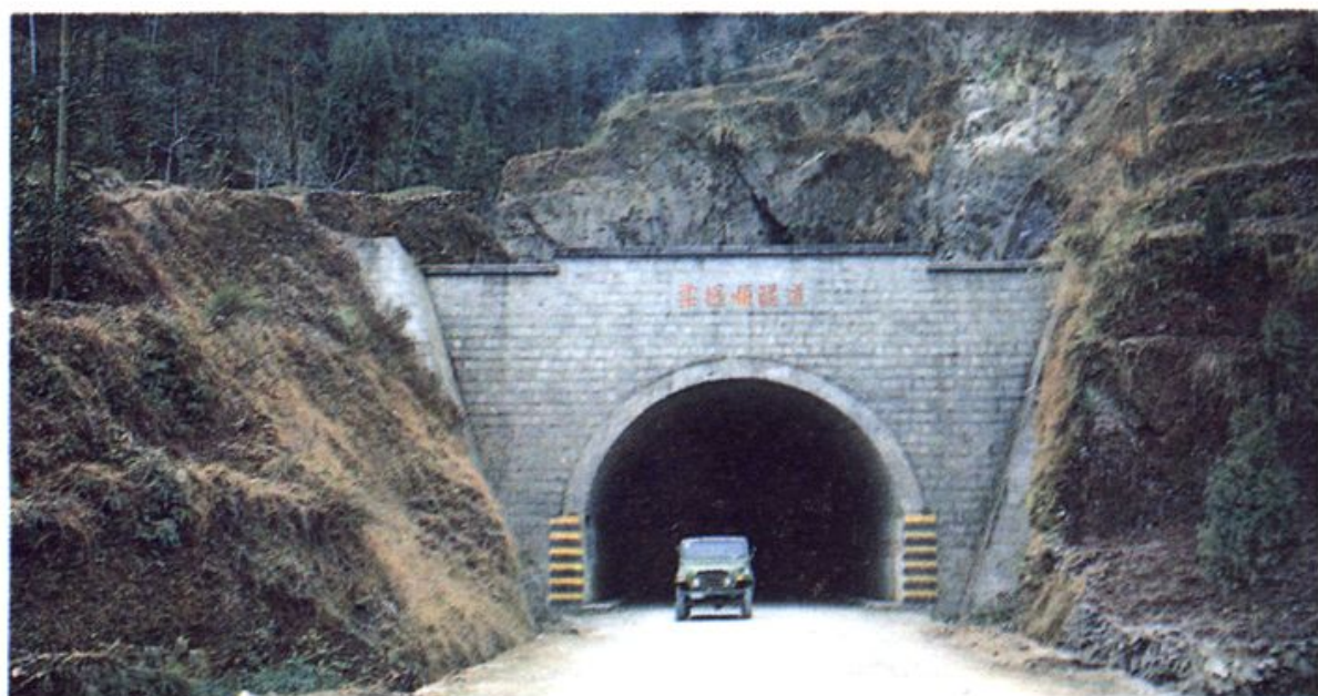
柔极岭公路隧道进口洞门
