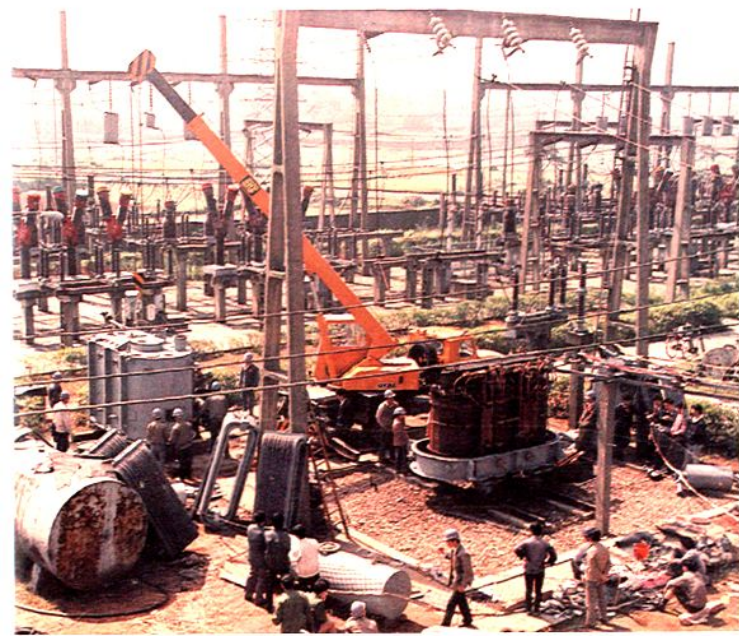
110 千伏主变压器吊芯检修
