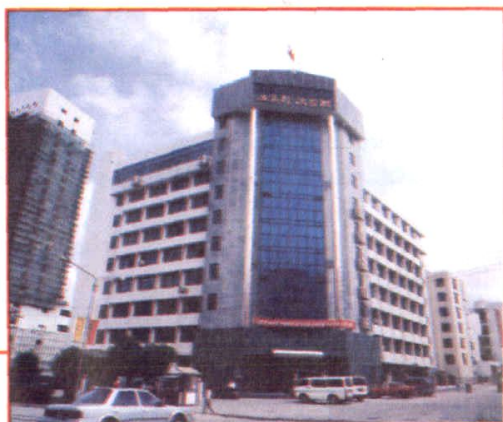
► 石狮市工商局办公大楼
