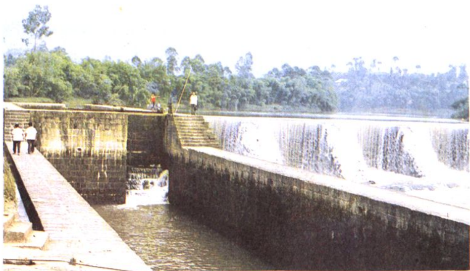
蒲吕闸坝 弧形拱坝溢细水， 深邃闸箱栏铁门。
