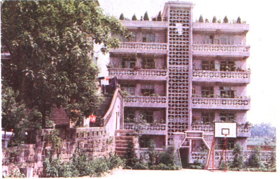
铜梁县公路养护段宿舍
