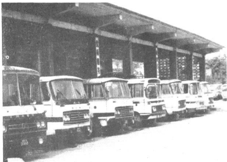
铜梁汽车站 客车停车库
