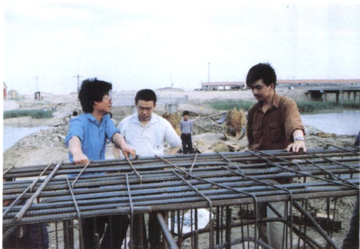
支脉河大桥施工工地
