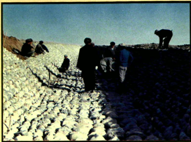
干砌卵石渠道的技术检查
