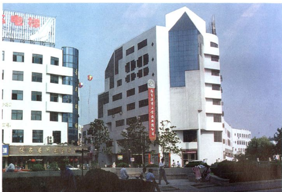
江苏荣盛集团公司(核心企业张家港市五金机械总公司)主楼外景
