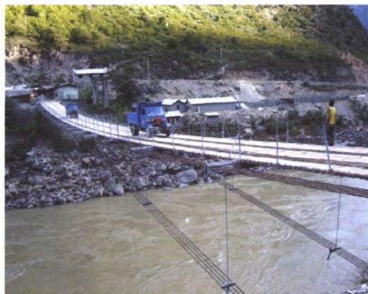
世界首座倒张式钢索吊桥——澜沧江甸尾桥
