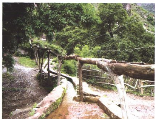
古老的引水木渡槽
