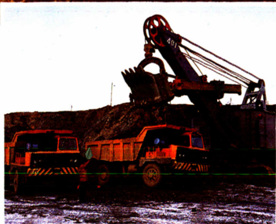
電鎬裝汽車 Loading Truck with Excavator
