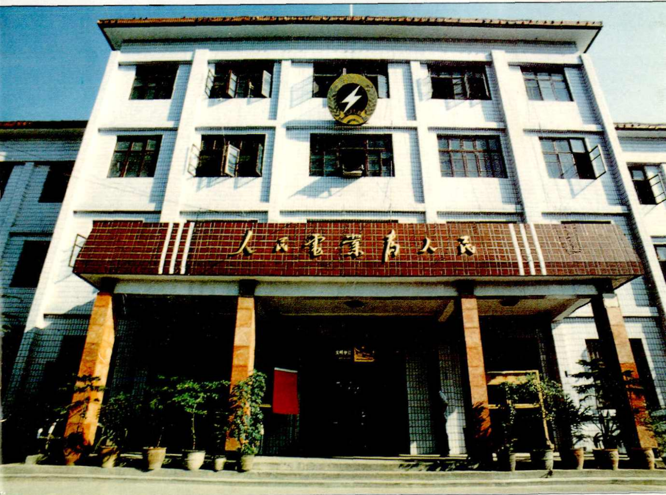
运城地区电业局办公大楼。
