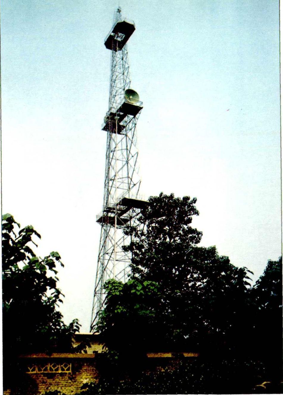
新绛微波站铁塔
