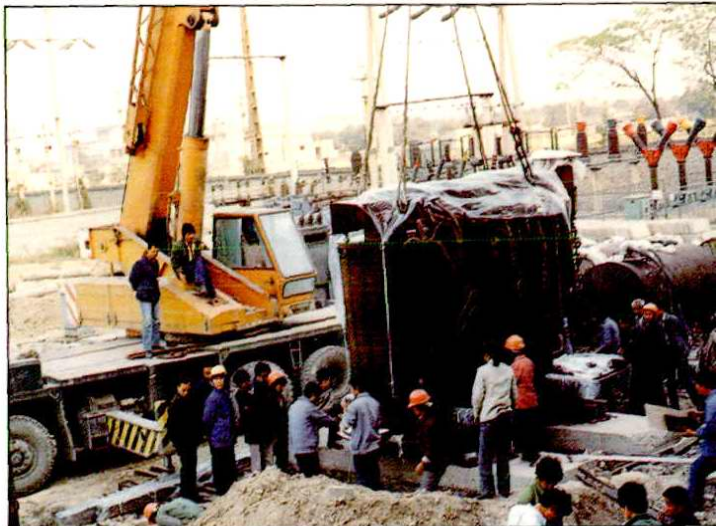
变电一工区在北郊变电站进行主变压器吊芯处理
