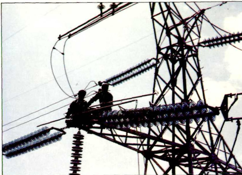
线路工区在 220 千伏线路上带电更换绝缘子
