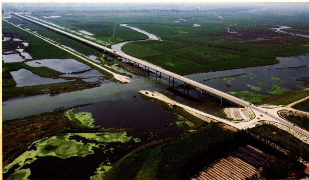
位于蒙洼分洪道上的中岗蒙洼防汛交通大桥（拍摄于2010年）
