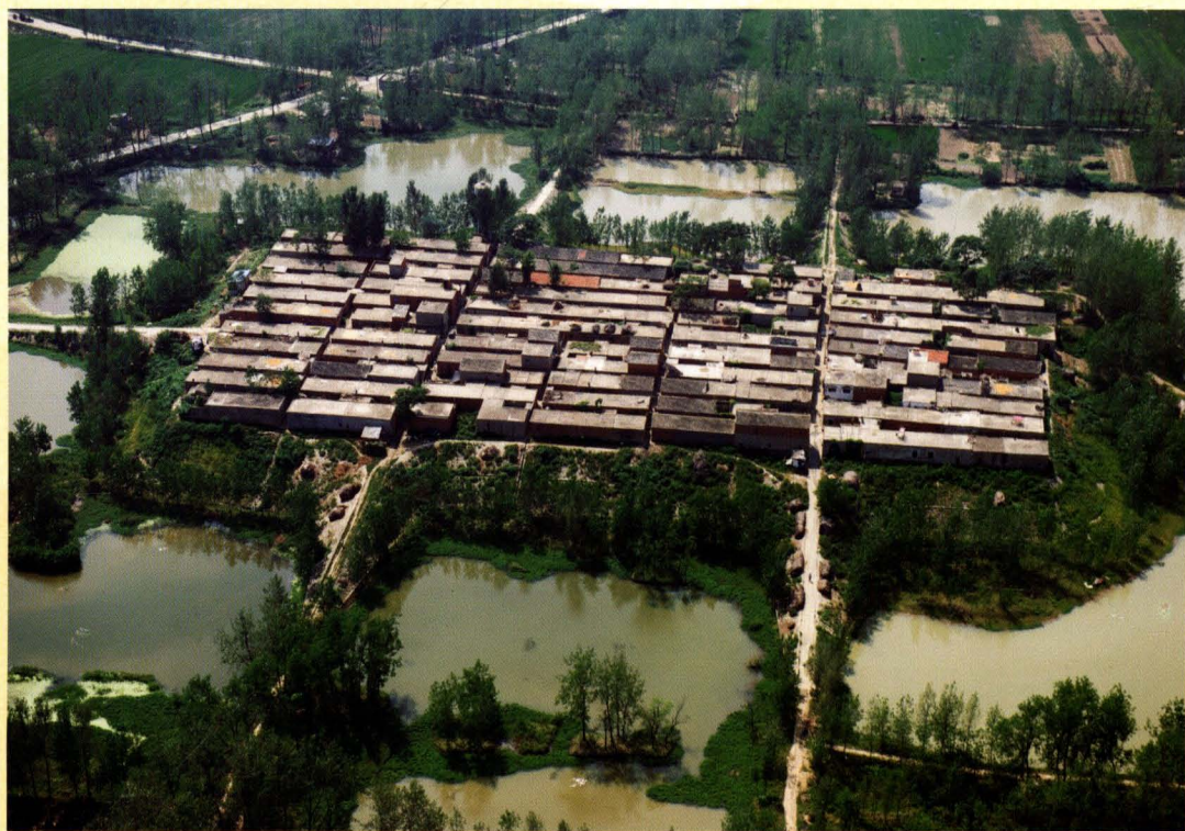
蒙洼蓄洪区庄台（拍摄于2008年）
