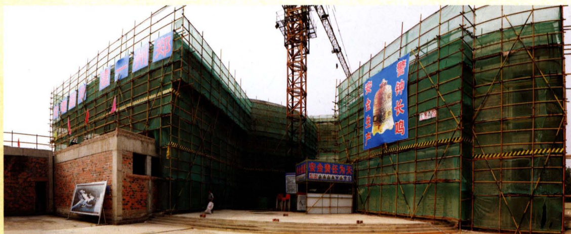
建设中的王家坝抗洪纪念馆（拍摄于2014年）
