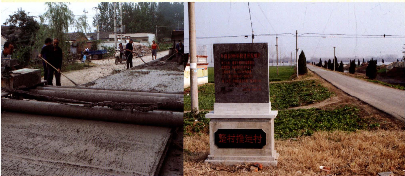
阜南县农村公路“村村通”工程
