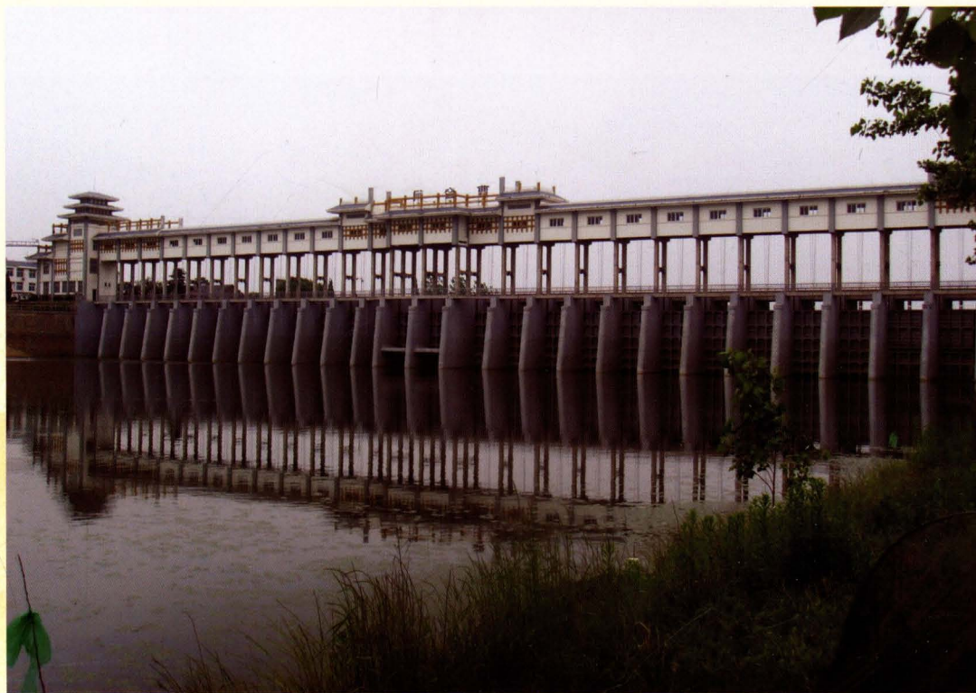
位于蒙洼蓄洪区尾部的曹台孜退水闸（拍摄于2010年）
