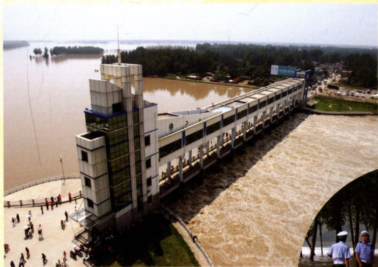
2007年7月10日，淮河王家坝闸第十五次开闸蓄洪
