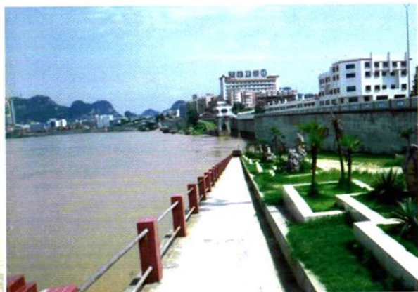
广西柳州市防洪堤
