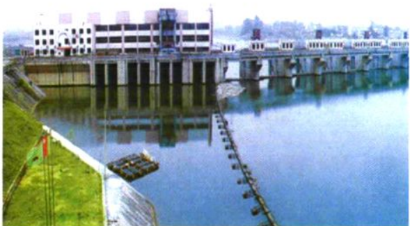
1996年建成投产的广东北江孟洲坝水电站
