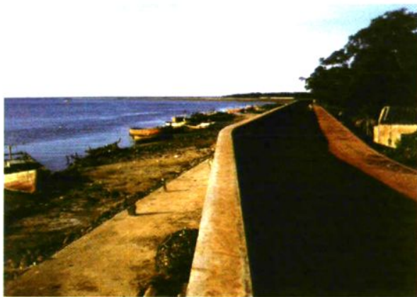
1999年建成的南渡江海口防潮海堤
