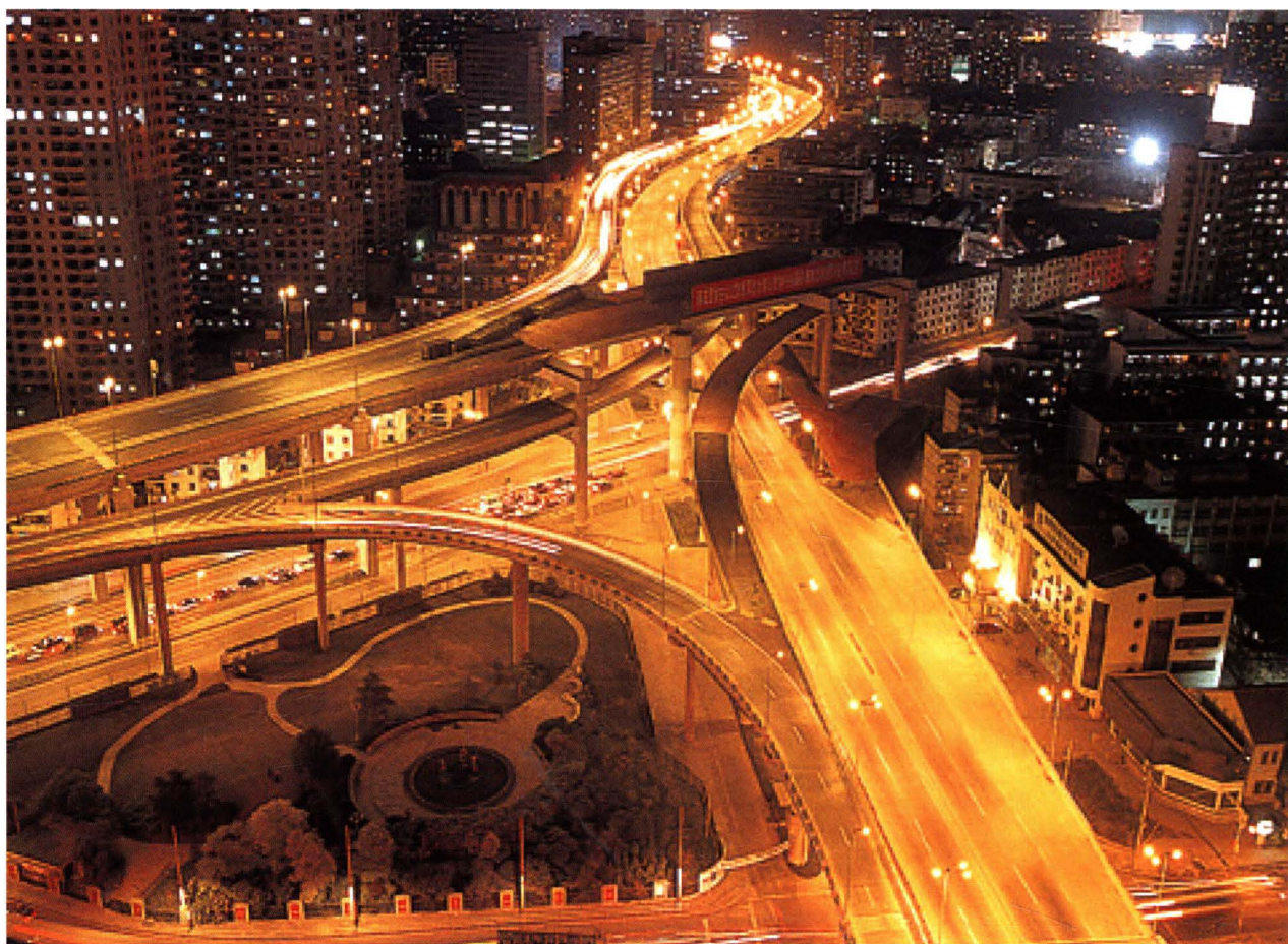
延安西路中山西路SW立交桥
