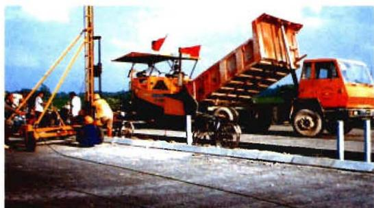
施工机械在铺筑路面，安装护栏
