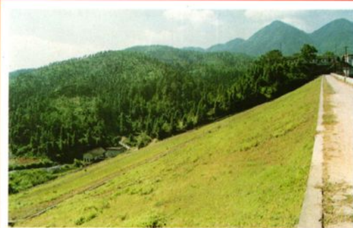
▲ 霞沙洲电站大坝
