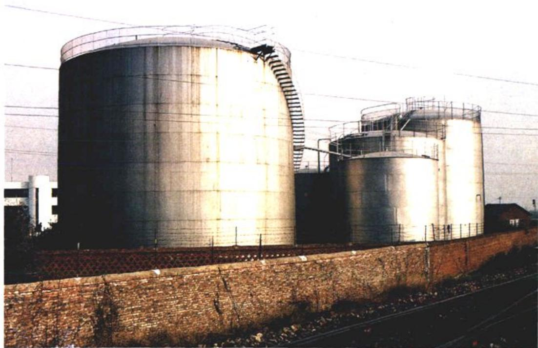
1986年焊制的座落于莒南国家粮食储备库的钢板油罐
