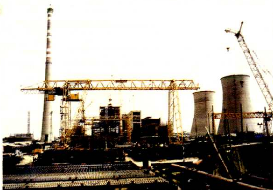
电厂工程建设组装机地
