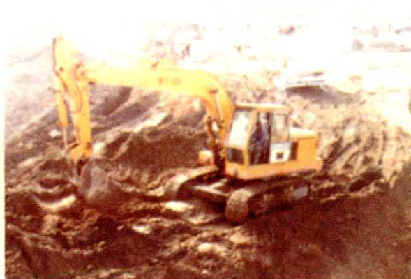
达电一期工程破土开挖
