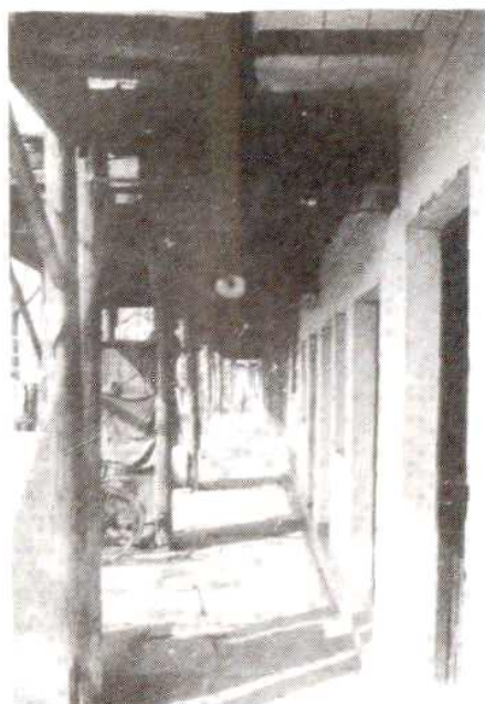
硖石米市旧址
