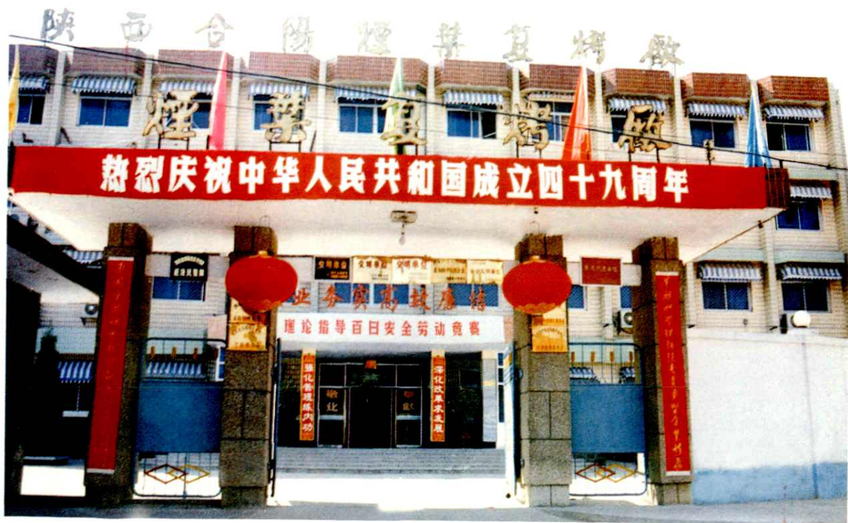
1989年修建的陕西合阳烟叶复烤厂办公楼
