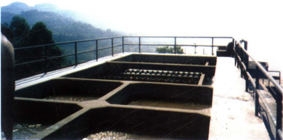
水厂消毒水池
