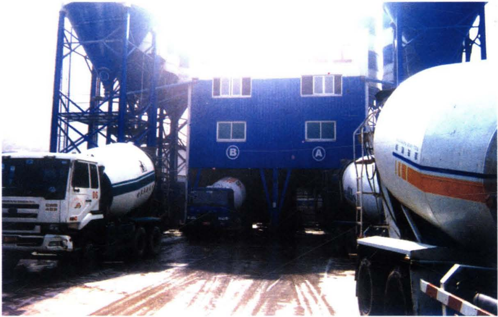
富皇混凝土搅拌站
