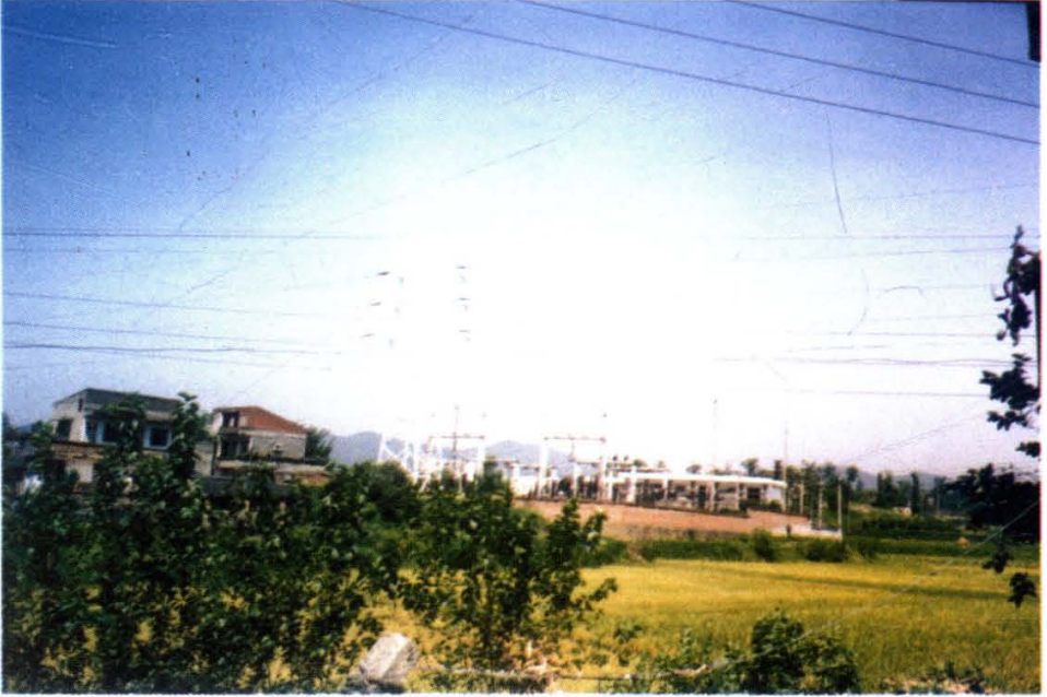
李家坝 11 万千伏变电站
