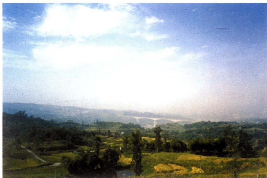
远眺渝合高速路马鞍石大桥
