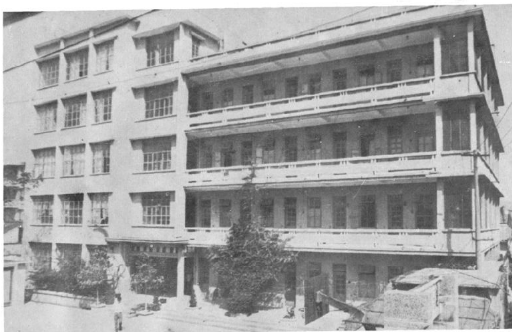
饶平县粮食局办公大楼 该楼建于1981年4月，1982年4月竣工。占地2.915亩，建筑面积2382平方米，计5层4厅50房。
