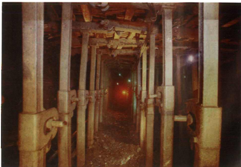
淮南市乡镇煤矿陶 圩二矿采煤工作面
