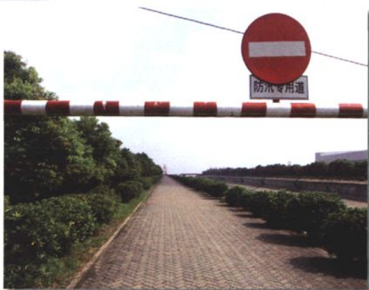
江堤上的防汛抗洪专用公路
