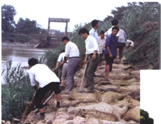
1991年7月6日，吴市乡机关干部、工作人员在金泾闸外抢险修堤
