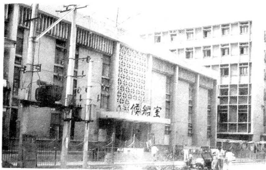
↑ 武穴港 候船室
