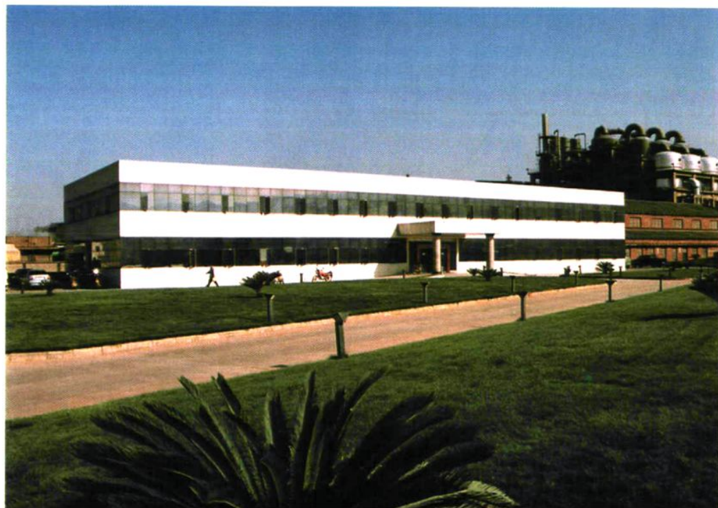
◀新建生产综合楼
