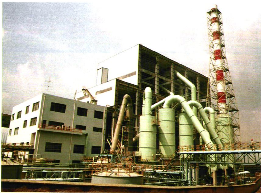
▲ 中美合资建设的60万吨/年 磷酸二铵生产装置
