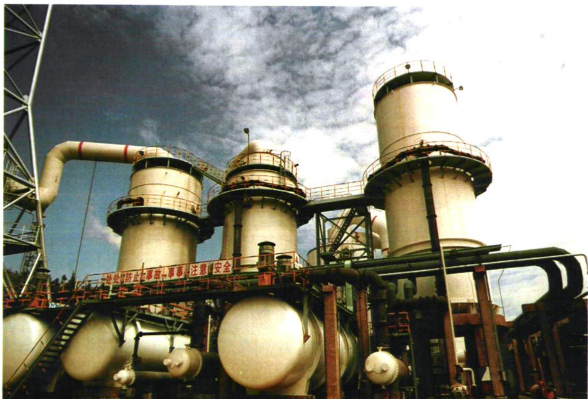
▼ 33万吨/年硫磺制酸装置
