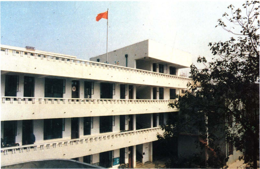
示范幼儿园教学楼
