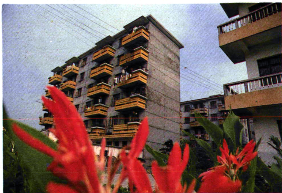
萧山县教工宿舍楼
