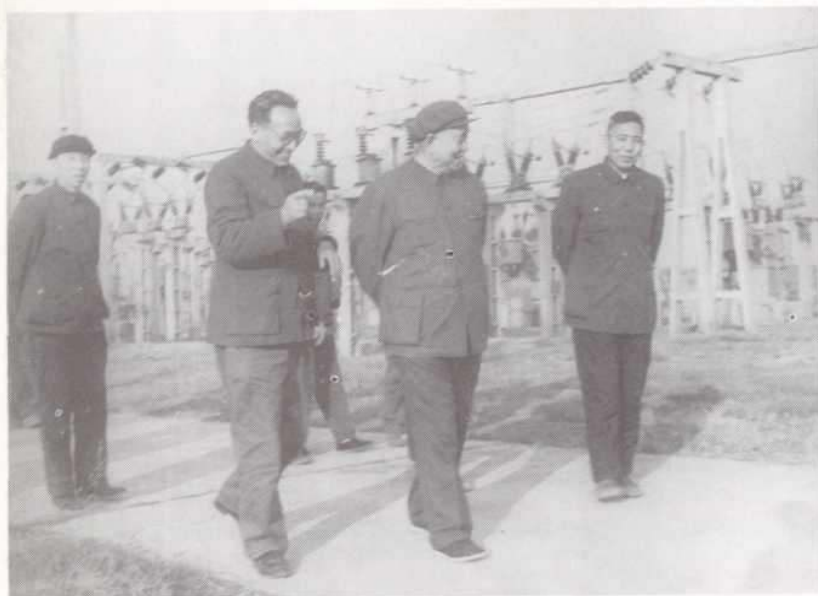
▲文化部部长黄镇视察横埠 110 千伏变电所
