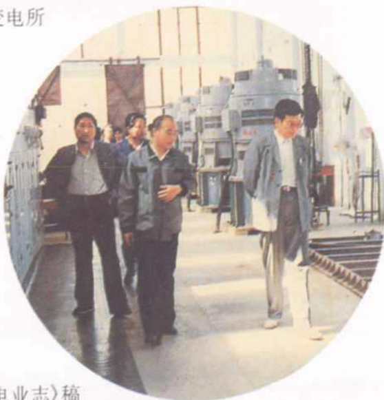
副省长邵明视察沙池电排站▶
