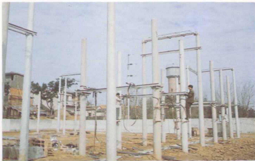
▼ 正在施工中的钱桥 35 千伏变电所
