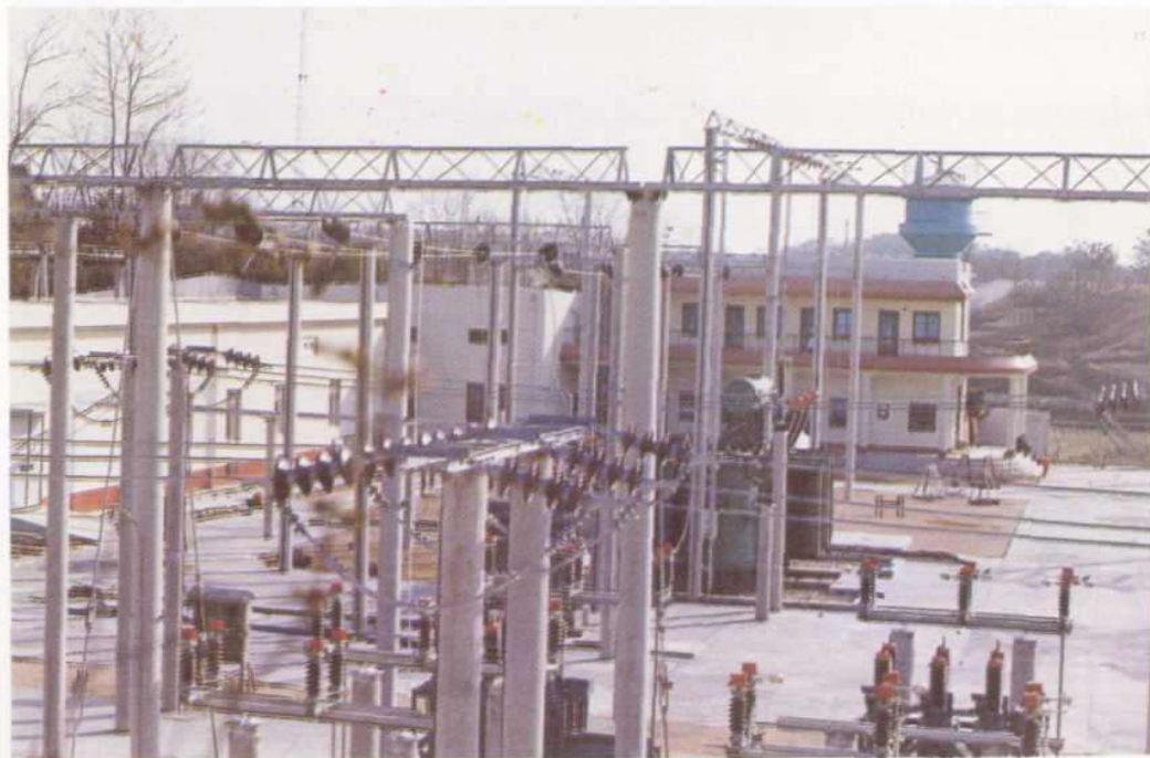
▲新建中的城关 110 千伏变电所
