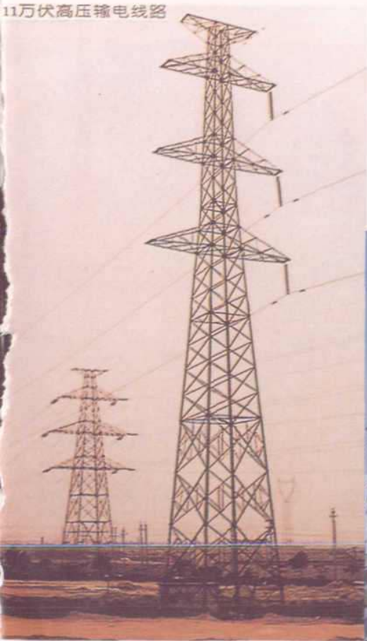
▼ 110 千伏高压输电线
