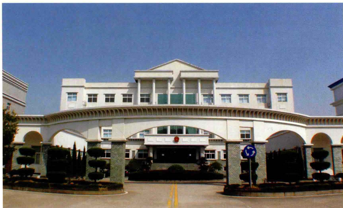
慈溪市人民法院周巷人民法庭
