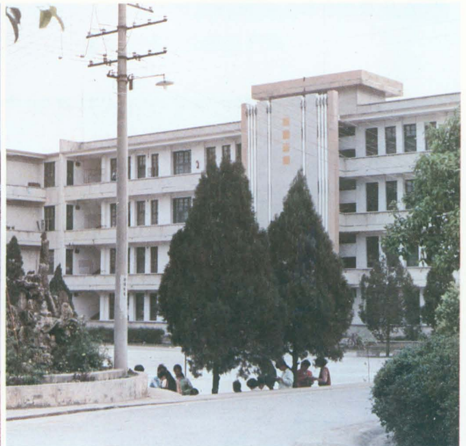
▲ 县高级中学办公楼
