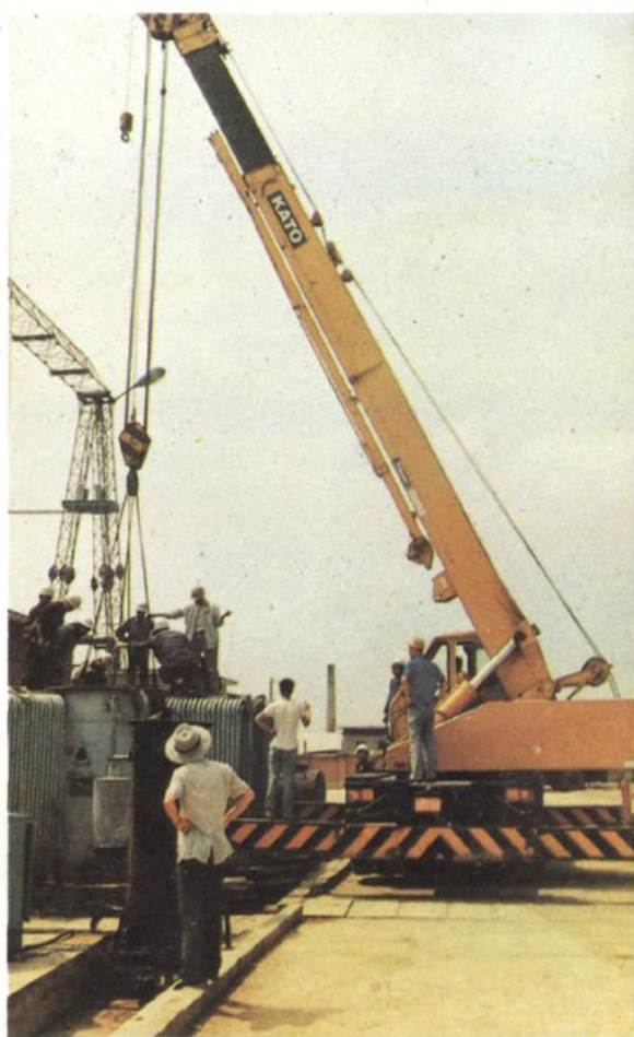
▲ 安装公司在吊卸变压器
