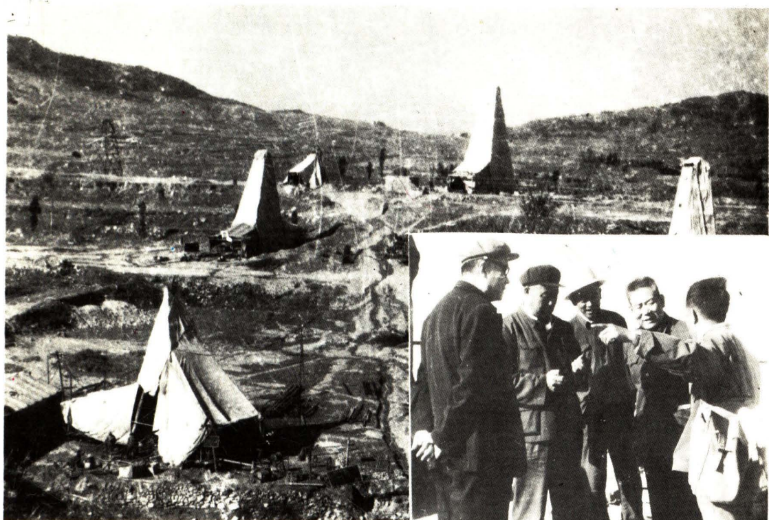
继莱芜铁矿之后，又一大型富铁矿床—— 淄河铁矿在勘查会战中。
