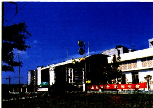
院设计的成都鲁能科华中路CNG加气站
