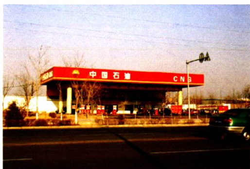
具有探索性的工程总承包项目 新疆库尔勒昆仑加气站
