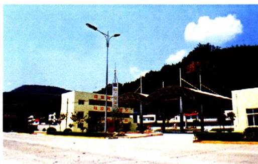
具有创新性的阆中神门关天然气储配站
