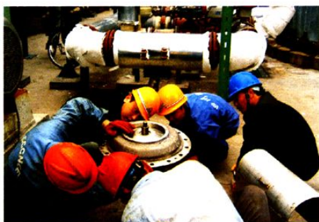
院科技人员在产品安装现场
