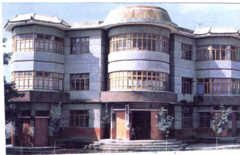
上图 饲料厂办公楼
