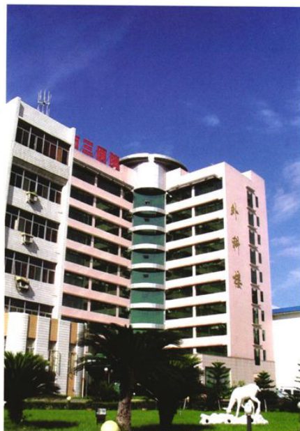
大外科楼外景
