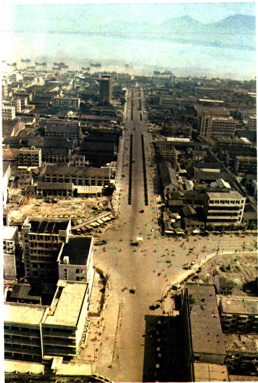
瞰看建设中的解放路 1985年 (航空拍摄) 金立新 摄
