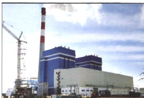
内蒙古北方联合电力临河热电厂工程
