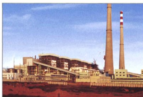
阳城电厂一期工程
