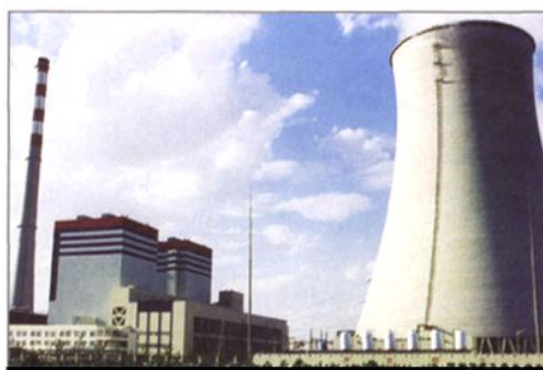
山西鲁能河曲电厂一期工程
