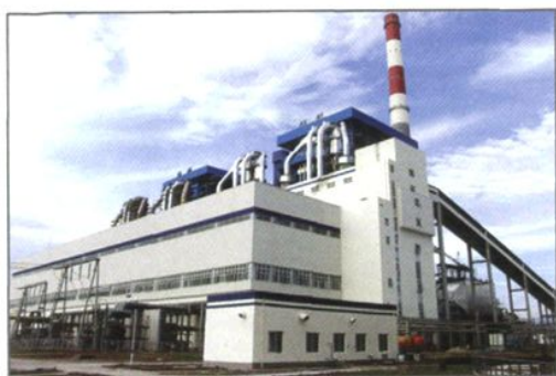
重庆合川双槐电厂工程
