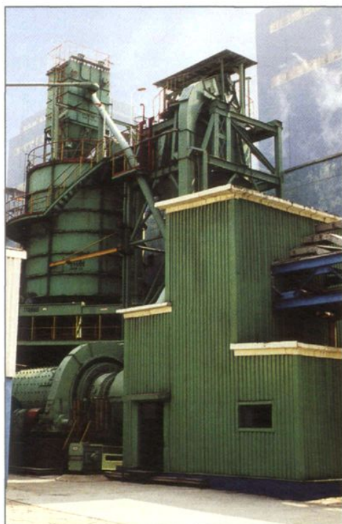
中日合作太原第一热电厂五期湿法脱硫工程
