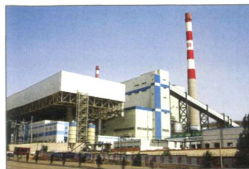
山西平朔煤研石电厂二期工程
