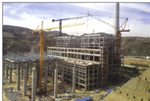
山西柳林宏光电厂工程
