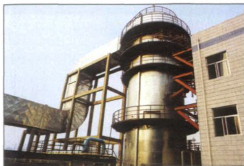
太原第一热电厂六期脱硫工程
