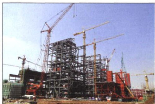
山西长治热电厂工程
