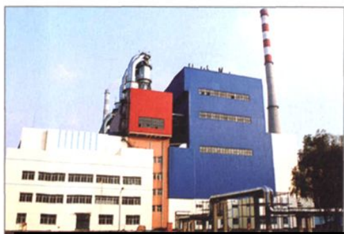
太原第二热电厂五期技改工程
