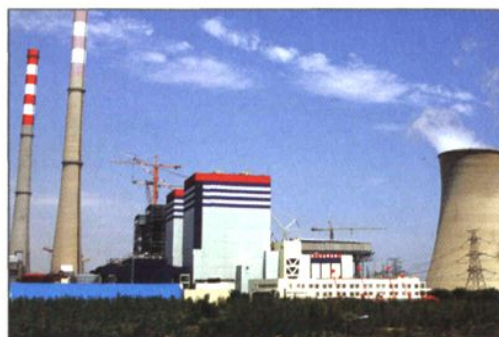
山西鲁能河曲电厂二期工程
