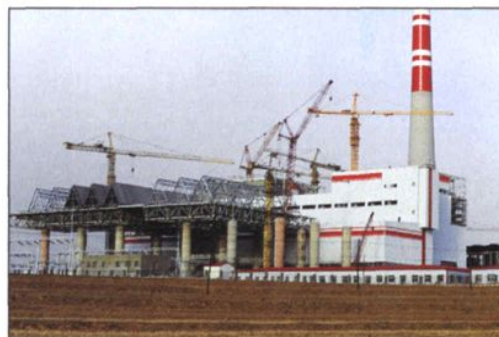
山西右玉电厂工程
