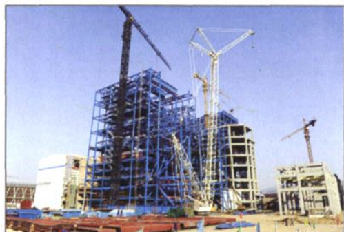
山西左权电厂工程
