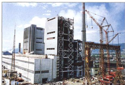
太原第一热电厂五期扩建工程
