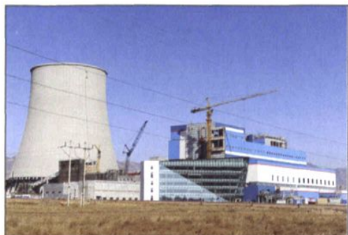
山西山阴电厂工程
