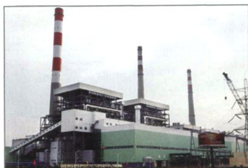
阳城电厂二期工程
