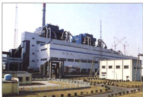
太原第一热电厂六期扩建工程
