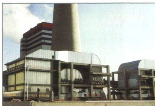
山西鲁能河曲电厂脱硫工程
