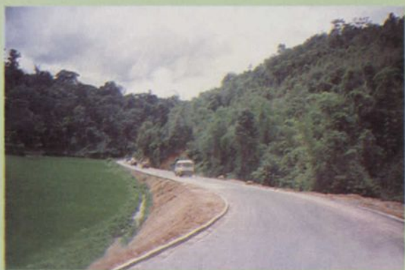
勐阿公路曼滚坡段
