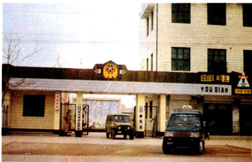
武邑县邮电局现址(县城建设西路北)
