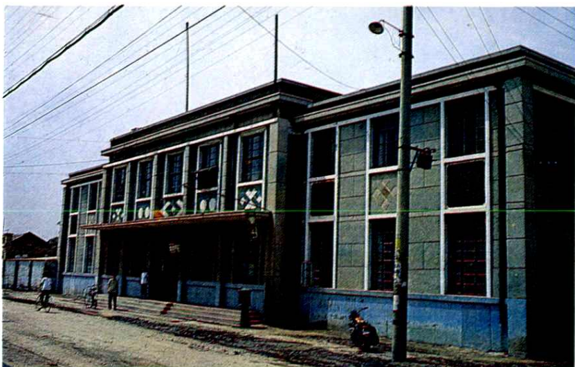
武邑县邮电局原址(县城西街)
