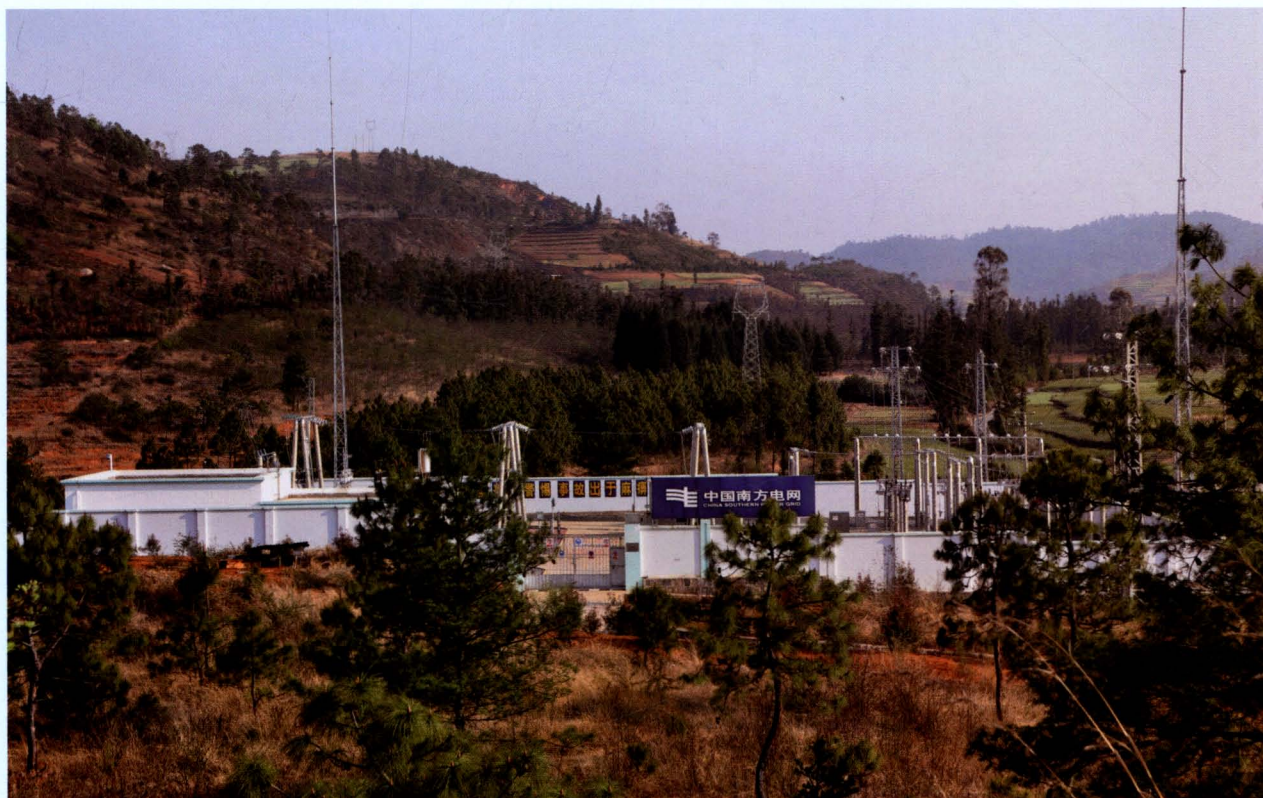
2011年6月14日竣工投运的35千伏富良棚变电站，站址位于峨山县富良棚乡小黄河村
