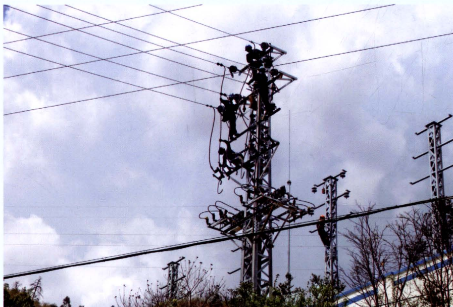
2013年3月27日，腾远实业有限责任公司进行玉溪市万昊工贸有限公司新建10千伏线路工程作业
