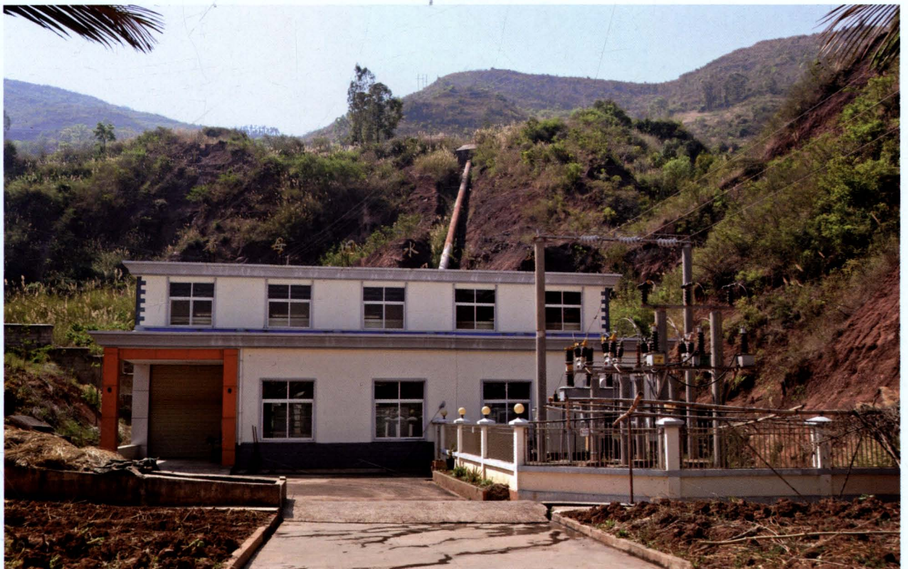
2008年5月并网发电的着母旧水电站，站址位于易门县十街乡着母旧村，装机容量为 2 \times 2.5 兆瓦
