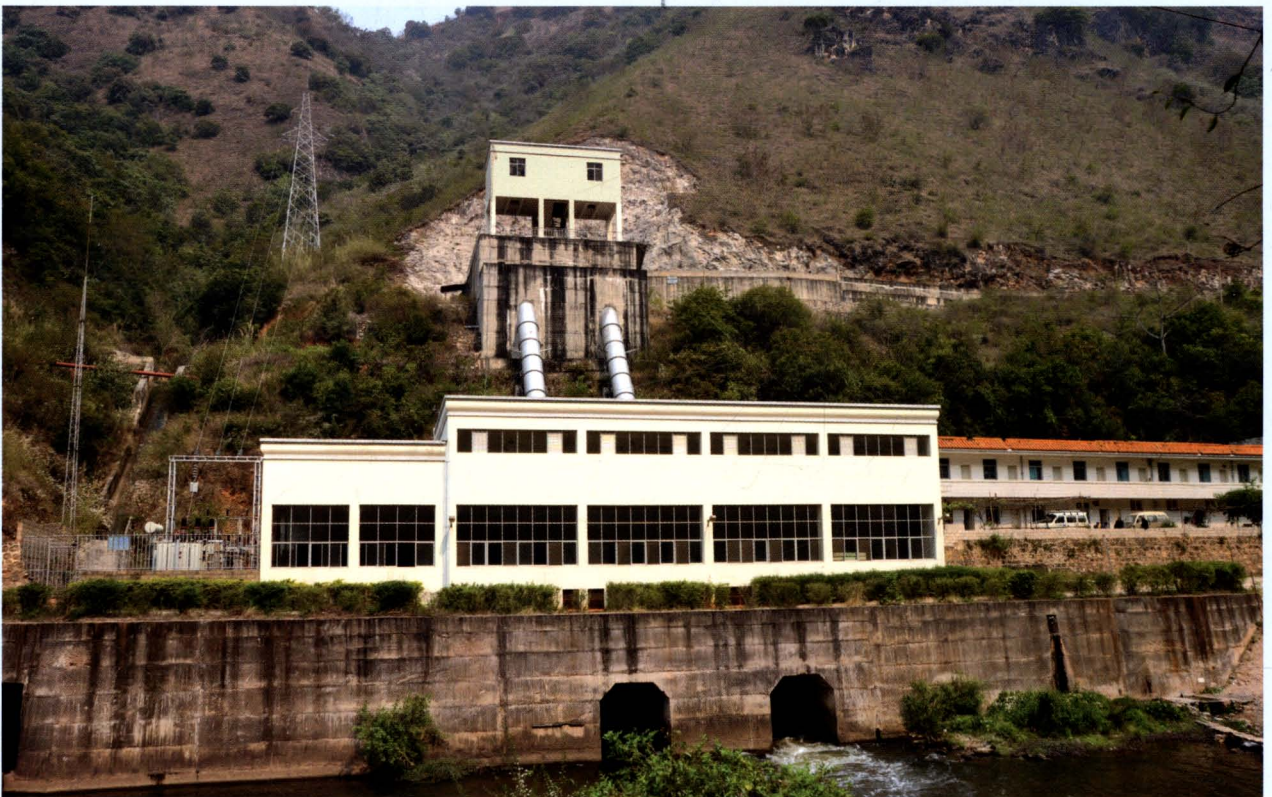
2006年5月并网发电的阿依水电站，站址位于峨山县小街街道阿依村，装机容量 2 \times 2.0 兆瓦
