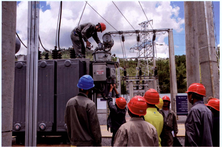
2011年6月8日，峨山供电公司完成35千伏富良棚变电站工程验收
