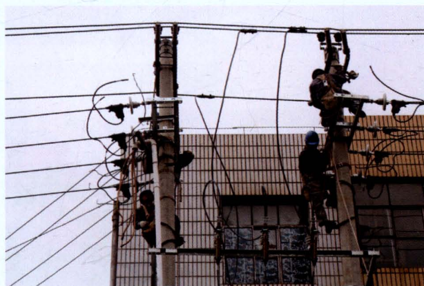
2012年9月，峨山供电有限公司首个“标杆台区”在小街片区建成
