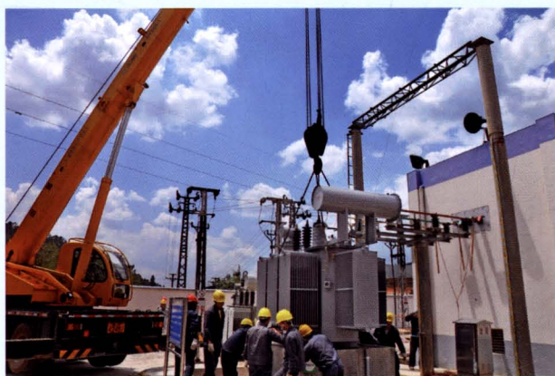
2012年6月7日，峨山供电有限公司完成35千伏高平变增容技改主变更换
