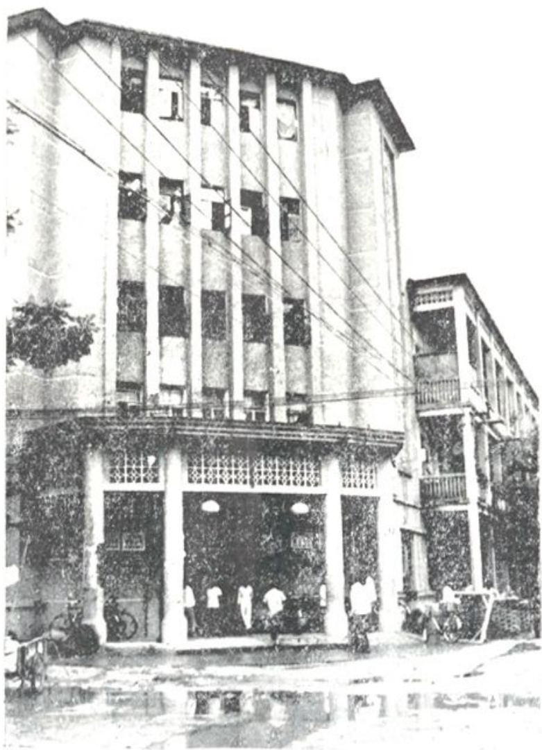
大埔县二轻工业公司办公大楼正面五层结构，位于东风路34号， 建于1974年，1982年竣工。
