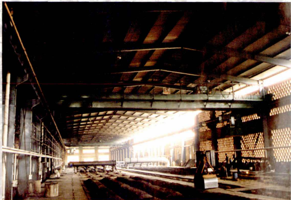
■ 平阴龙正焙烧有限公司新上3.5万吨焙烧炉生产线场景
