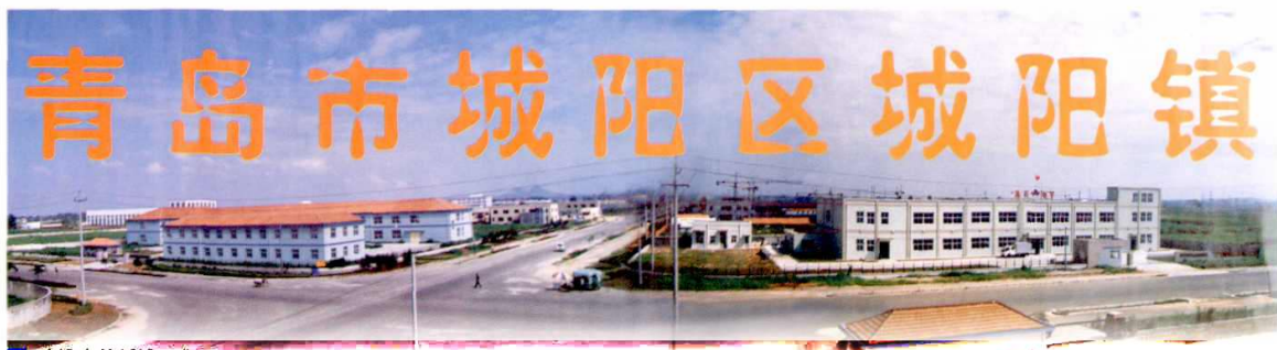
■ 建设中的新城工业园
