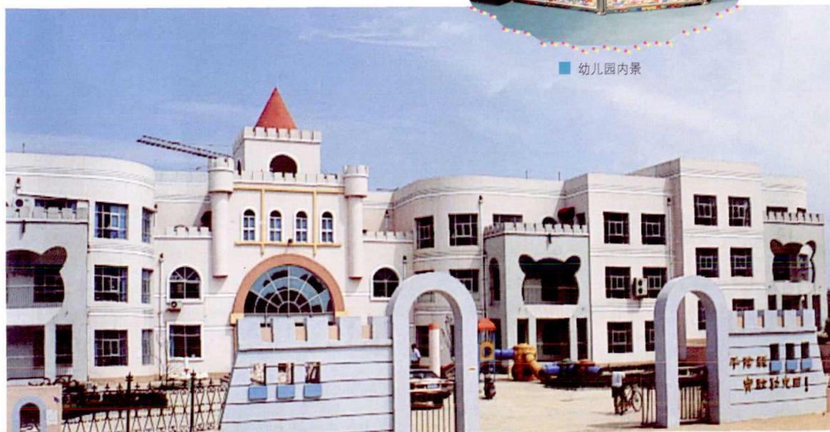
■ 由东关村投资 700 余万元兴建的省级实验幼儿园外景
