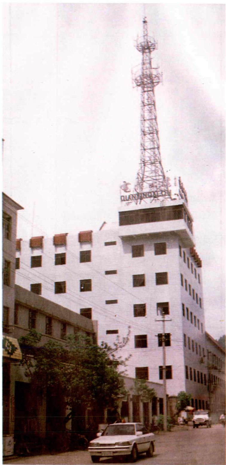
崇义县邮电大楼外景
