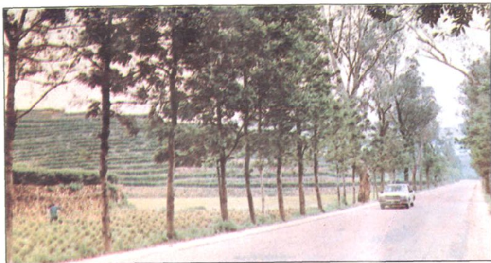
国道104线在福建境内福安 郊外一段公路
