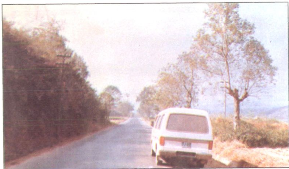
国道205线在福建境内浦城 深坑至上杭山子路段
