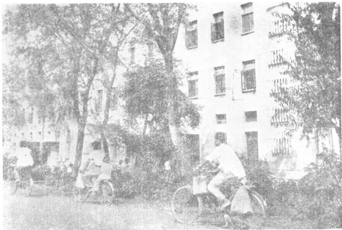
三井供销社大楼
