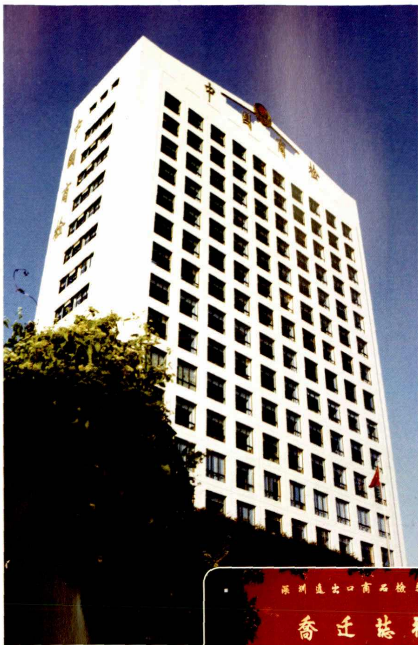
皇岗福民新村福强路1011 号深圳商检局检验办公楼 (1995~1999年)
