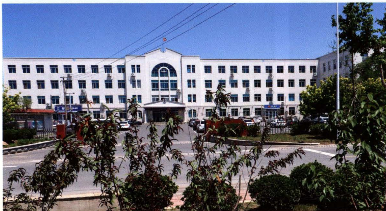
街道机关办公楼
