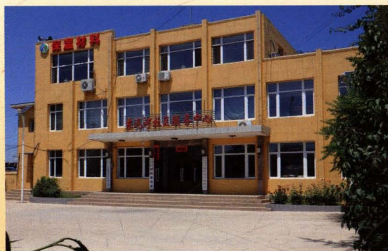
东泥河村委会办公楼
