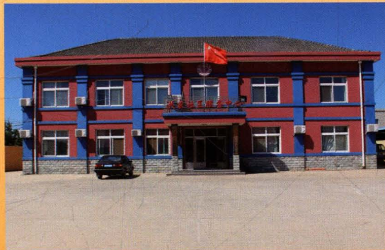
洪家村委会办公楼
