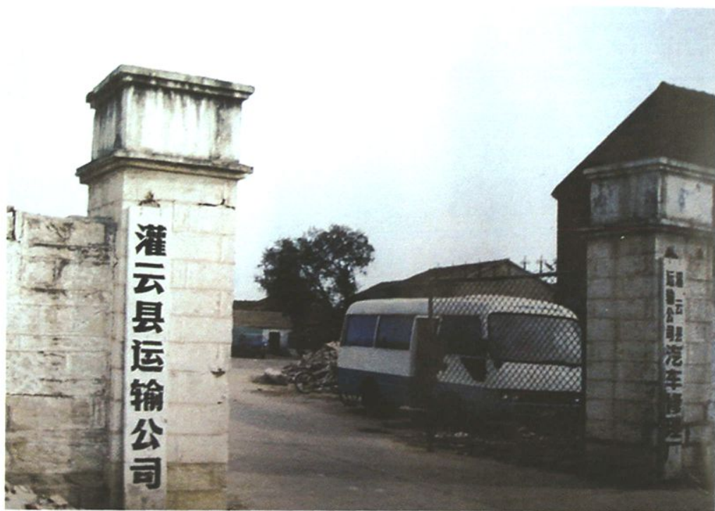
县恒通有限公司旧址
