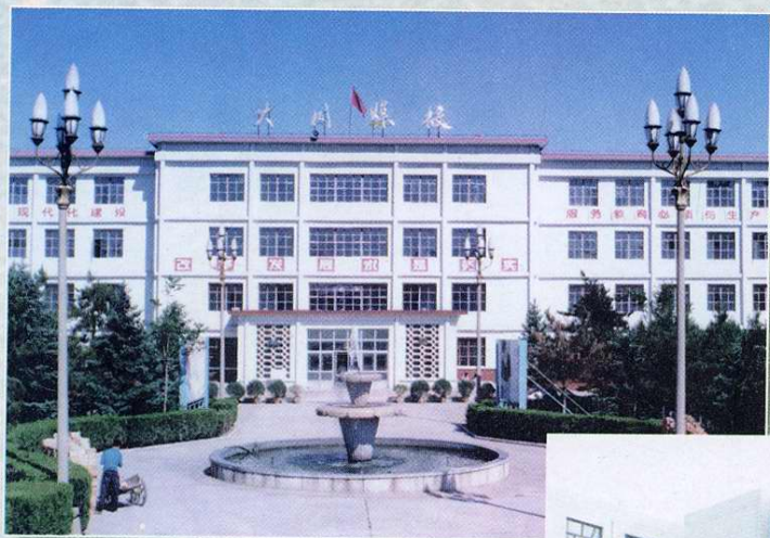
1978年建成的现办公大楼
