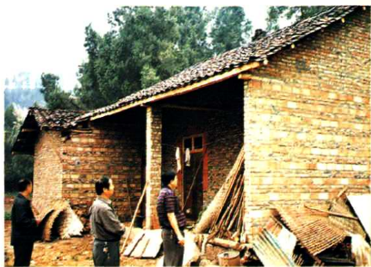
8月20日洪灾发生后3个多月，民政局把灾民倒房的恢复重建工作作为救灾的重中之重，全面启动“安身房”建设，投入大量救灾资金，使恢复重建质量高、进度快、效果好。图为县民政局、蓬萊镇领导走村入户验收重建房屋情况
